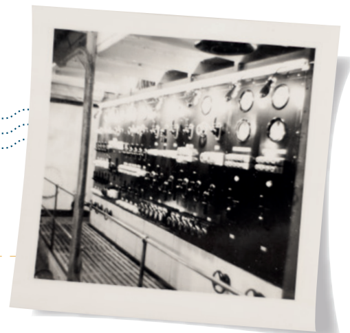
Huvudinstrumenttavlan. Vid gång genom Suezkanalen hade elektriker orden om ständig instrumentvakt.
